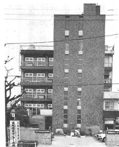
新校舎増築(2F) 3月20日竣工
